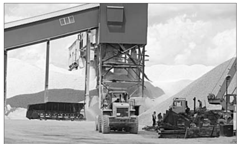
ИДЕТ УСТАНОВКА НОВОГО ДРОБИЛЬНОГО КОМПЛЕКСА.
