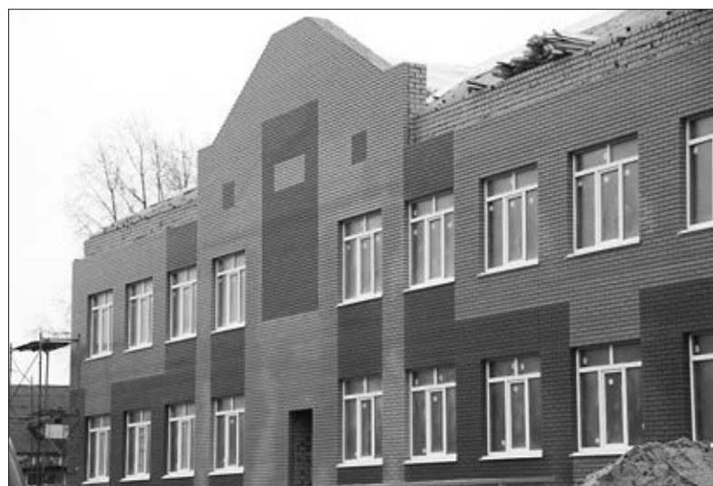
Идет строительство детского сада в селе Лавы.
