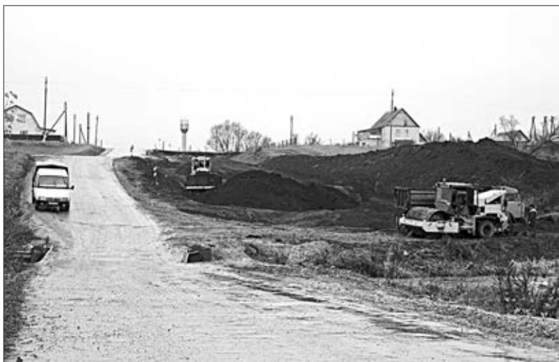
Дорожные работы ведутся и на левом, и на правом берегу Быстрой Сосны.
