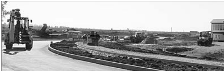
На промышленной площадке ведется масштабное строительство.
