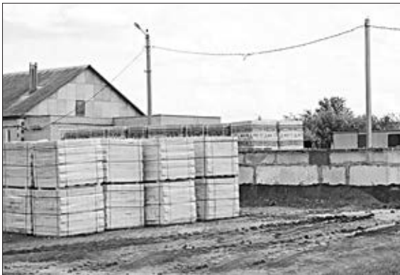
В селе Лавы возводится пристройка к школе.
