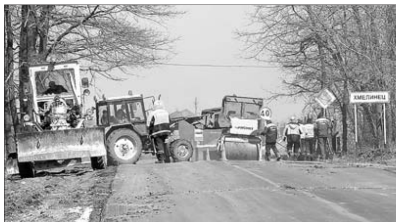
ДОРОЖНЫЕ РАБОТЫ В ПОСЕЛКЕ ИДУТ ПОЛНЫМ ХОДОМ.
