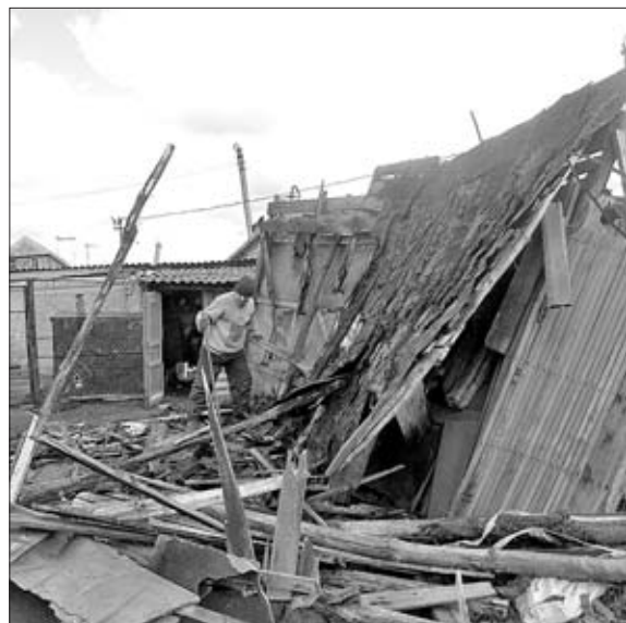
ВЕТХИЕ САРАИ В ПОСЕЛКЕ ГАЗОПРОВОД БУДУТ СНЕ- СЕНЫ. РАБОТА НАЧАЛАСЬ.
