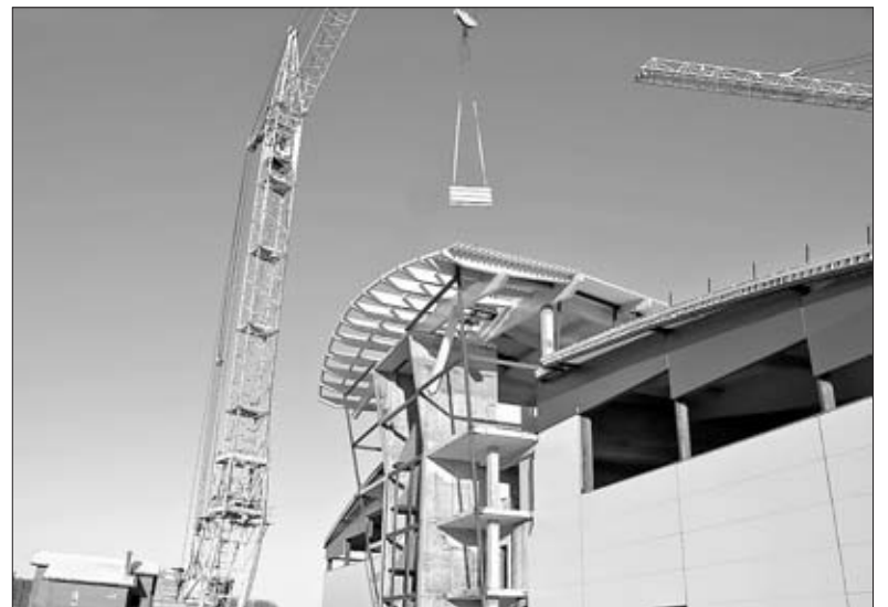
ИДЕТ СТРОИТЕЛЬСТВО ФИЗКУЛЬТУРНО-ОЗДОРОВИТЕЛЬНОГО КОМПЛЕКСА В ПОСЕЛКЕ КЛЮЧ ЖИЗНИ.
