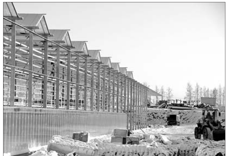
ПРОИЗВОДСТВЕННЫЕ КОРПУСА ТЕПЛИЧНОГО КОМБИНАТА «ЕЛЕЦКИЕ ОВОЩИ».
