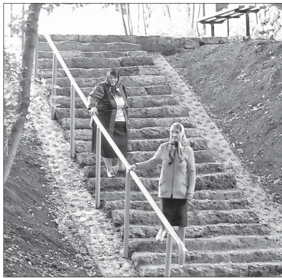
ПО ЛЕСТНИЦЕ К ЗОНЕ ОТДЫХА МОЖНО СПУСКАТЬСЯ БЕЗ ОПАСКИ.
