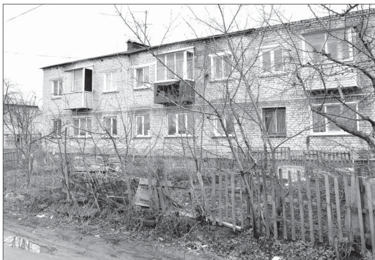
А ЭТО УЛИЦА В ПОСЕЛКЕ ГАЗОПРОВОД.
