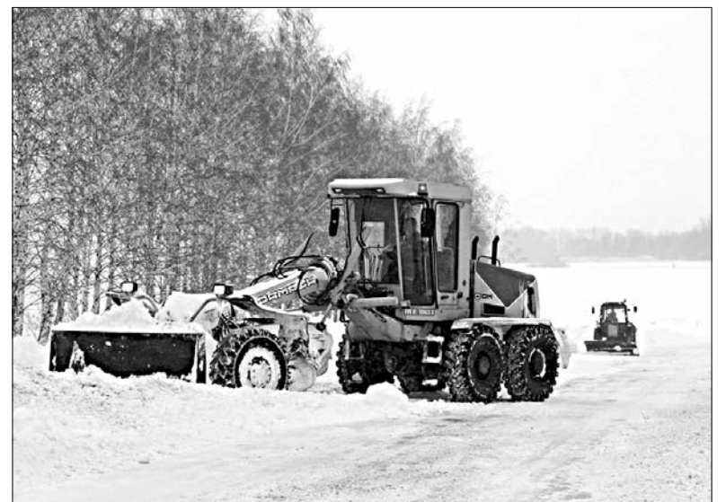
ИДЕТ ОЧИСТКА ТРАССЫ В С. ДОЛГОЕ ТЕХНИКОЙ ОГУП «ЕЛЕЦДОРСТРОЙ-РЕМОНТ».
