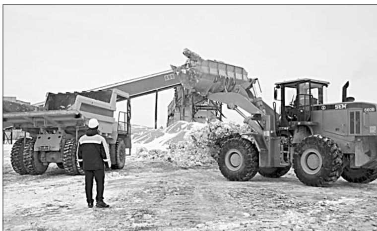
ПОЛНЫМ ХОДОМ ИДЕТ РАБОТА В ООО «КАМЕННЫЙ КАРЬЕР «ГОЛИКОВО».
