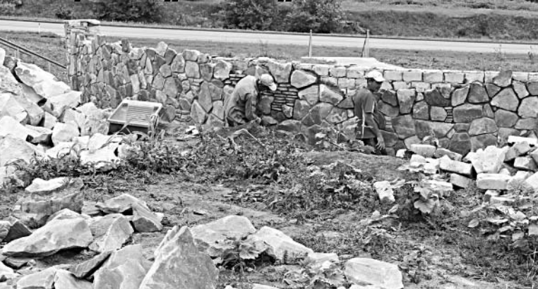
Облицовка стен идет полным ходом.
