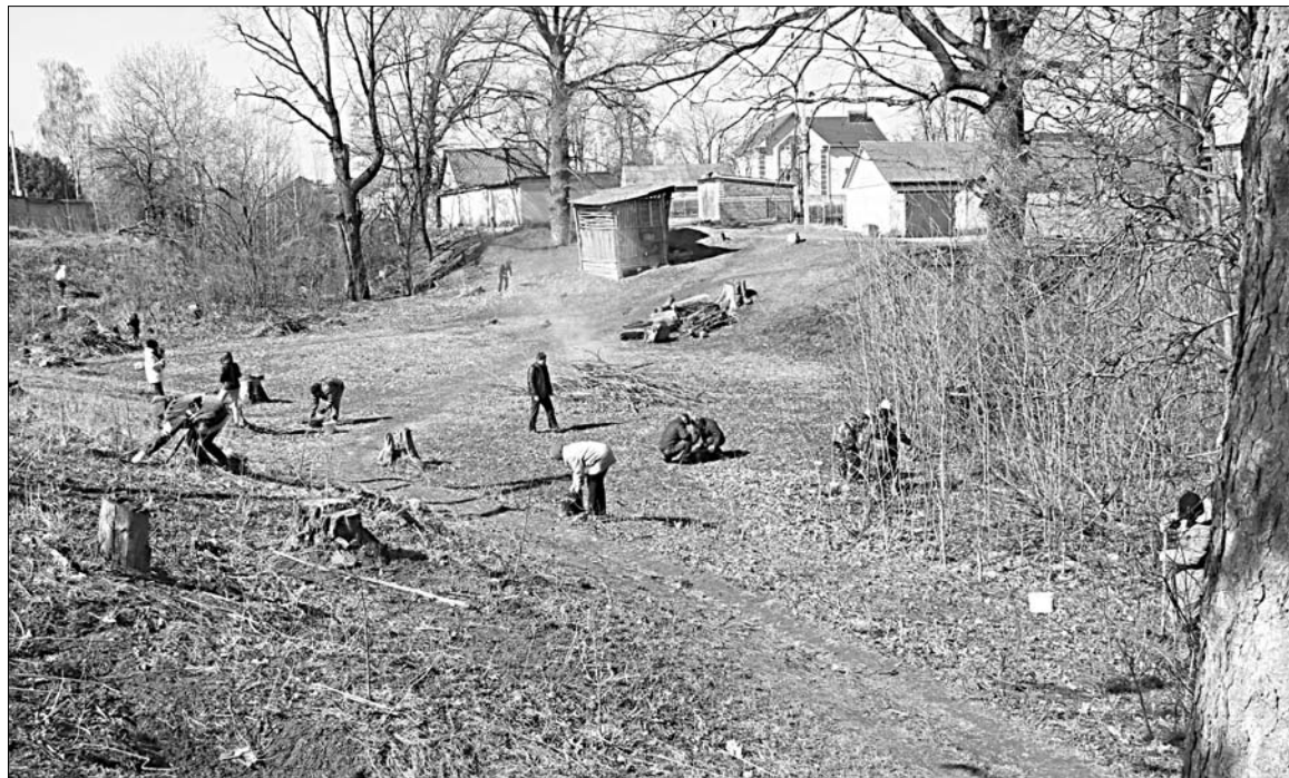
Работники администрации очищают овраг на ул. Мирной.
