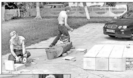
В офисе врачебной практики пандус обкладывают плиткой.
