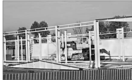
Идет строительство цеха по переработке ливера.
